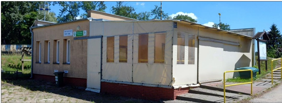
Rys. 66 Widok główny obiektu Świetlica Wiejskiej w Mokrym Dworze zarejestrowany z kierunku północno-zachodniego.
