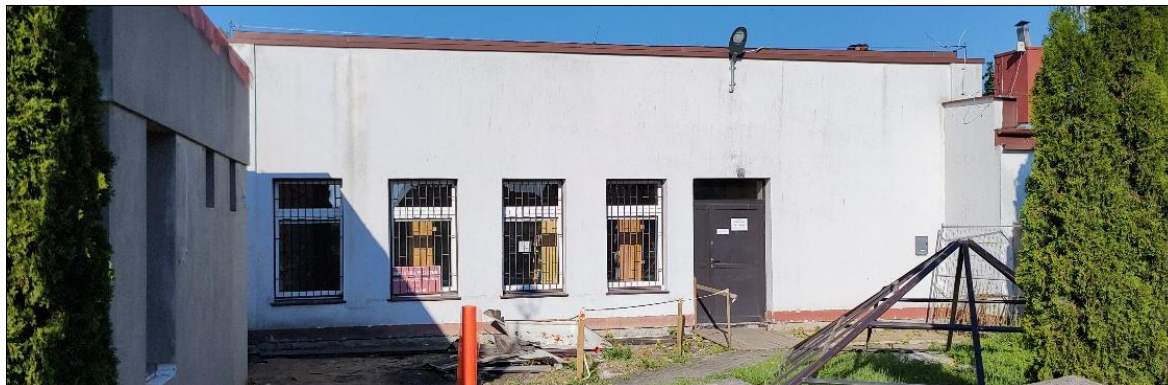
Rys. 78 Widok fasady z wejściem głównym do obiektu Świetlicy Wiejskiej w Wiślinie zarejestrowany z kierunku wschodniego.
