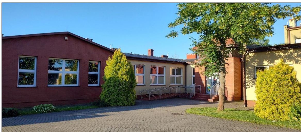
Rys. 34 Widok lokalny obiektu Szkoły Podstawowej im. Orła Białego w Wiślince zarejestrowany z kierunku północnego.
