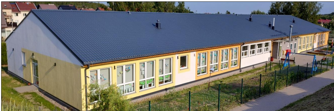
Rys. 26 Widok główny obiektu Gminnego Przedszkola w Straszynie zarejestrowany z kierunku północno-wschodniego.
