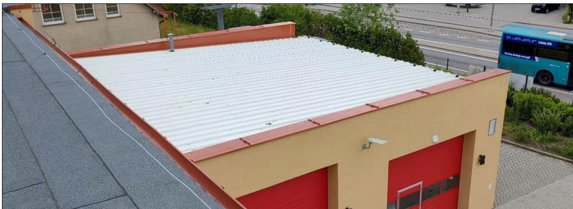
Rys. 46 Widok główny obiektu Ochotniczej Straży Pożarnej w Łęgowie zarejestrowany z kierunku północno-zachodniego.
